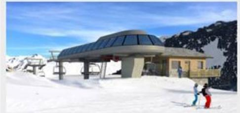
Cet hiver c'est le remplacement du télésiège Comborcière qui facilitera l'accès à Arc 1600 depuis le bas de la Vallée de l'Arc. Pour remplacer le télésiège à pinces fixes de Comborcière, le choix a été fait d'installer un télésiège débrayable 4 places rénové, qui sera deux fois plus rapide que le précédent. Cet appareil à la mécanique simple et robuste assurera en effet un débit de 2400 personnes/heure.
